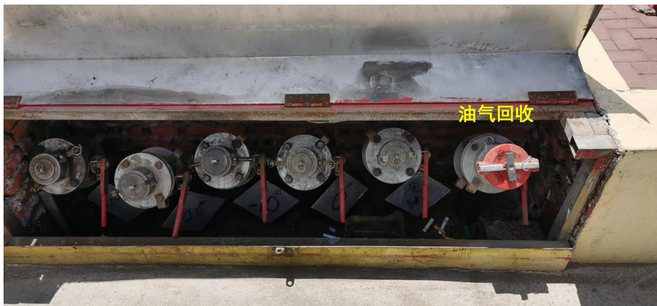
附图 3 一级油气回收系统（卸油油气回收）
