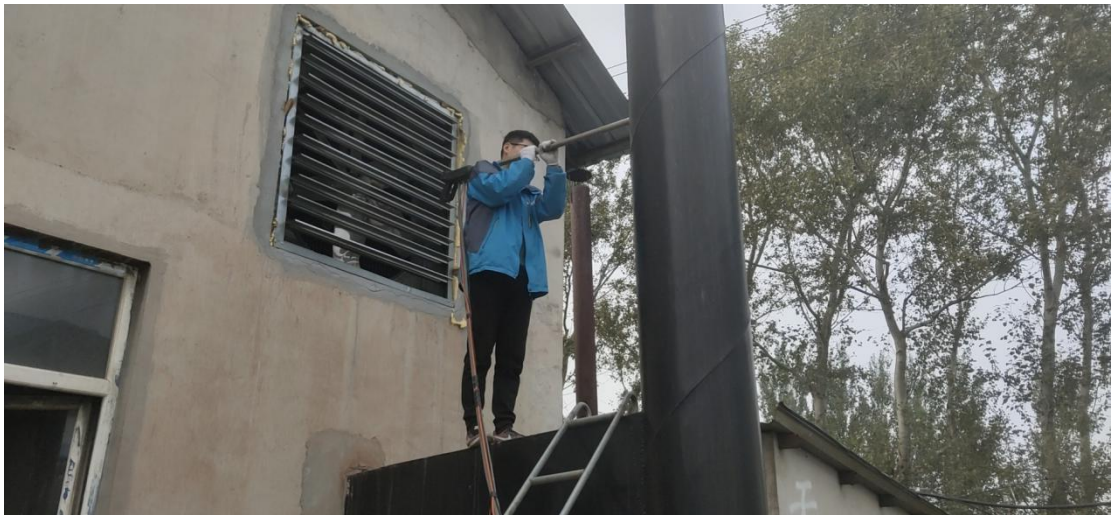
锅炉现场采样图片
